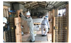
型枠組立(静岡)
