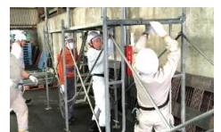
足場組立(福岡)
