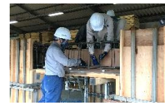
鉄筋組立(静岡)
