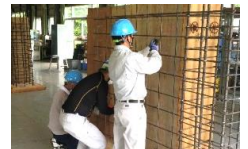
鉄筋組立(兵庫)
