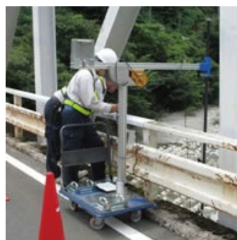
N式小型橋梁点検 システムによる点検
