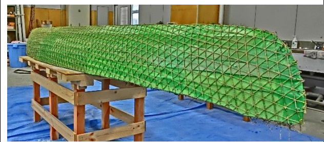
型枠組立、アラミド繊維配置完了
