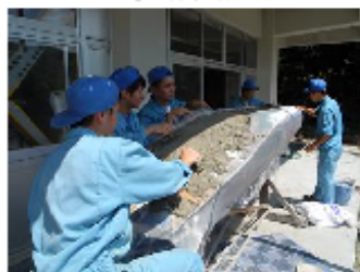
③ モルタル打設
