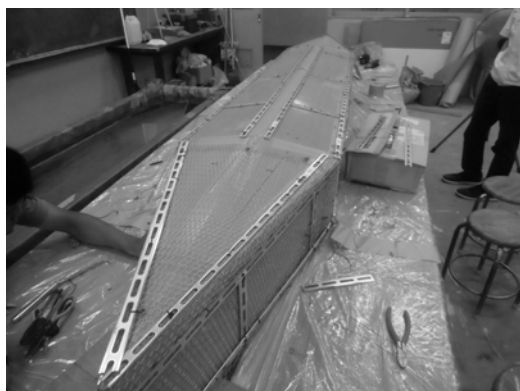
船体型枠・補強用の鉄プレート
