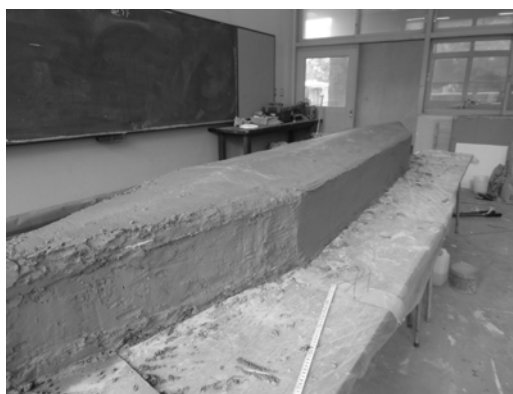
打設完了の様子
