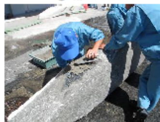
③ コンクリート打設
