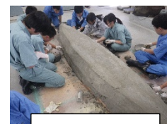
モルタル打設
